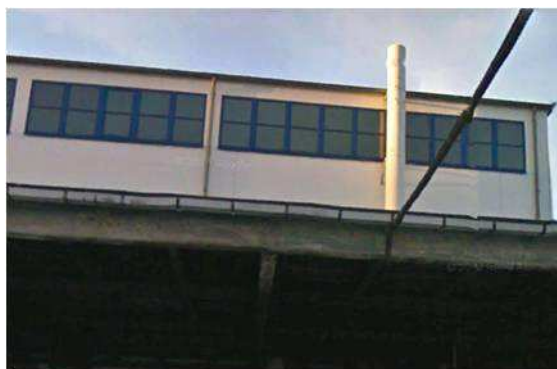
Figur 9-4 Afkastene på Maskincentralen når i dag op i en højde af 12 m over jordoverfladen, men skal med projektforslaget være 8 m højere, dvs. i alt 20 m.
