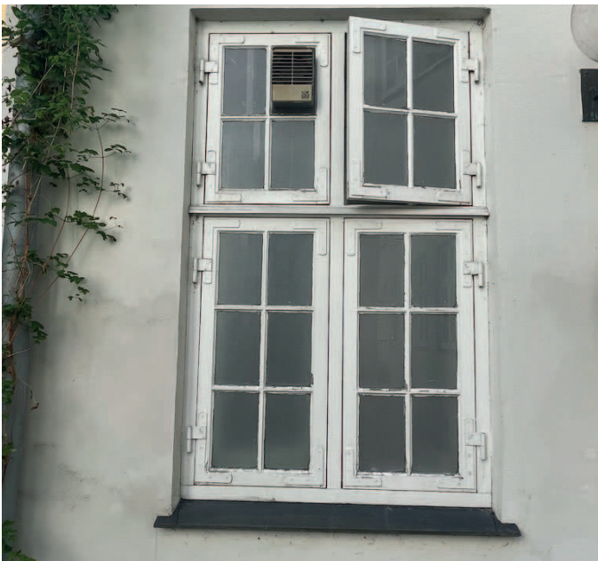
Oprindelige vinduer istandsættes og energioptimeres
