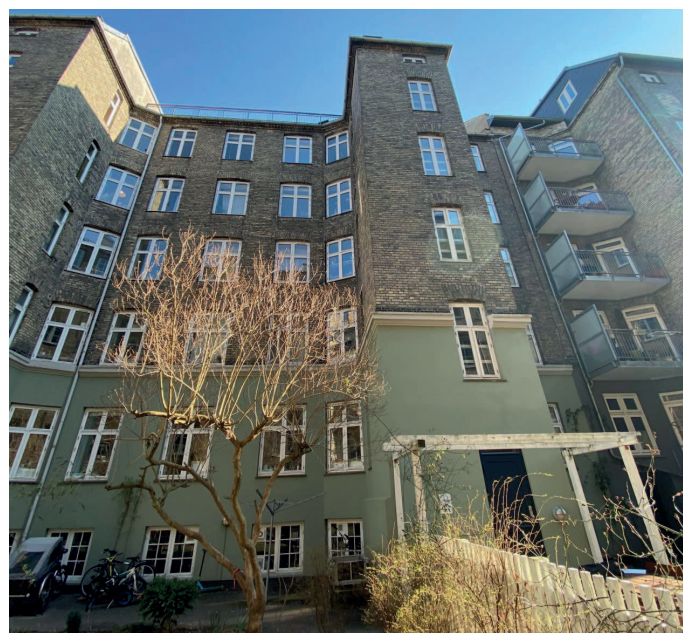
Trappetårne isoleres udvendigt
