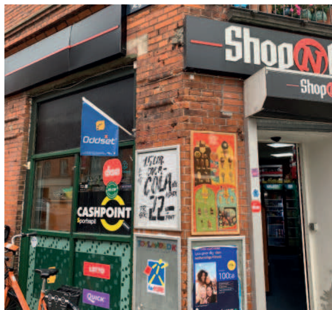
Udbedring af murværk og underfacade
