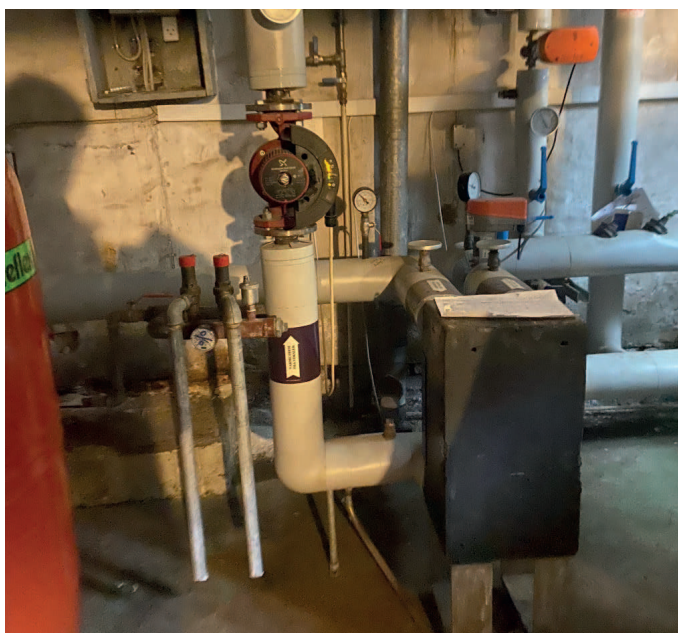
Varmeanlæg og vandinstallationer energiforbedres
