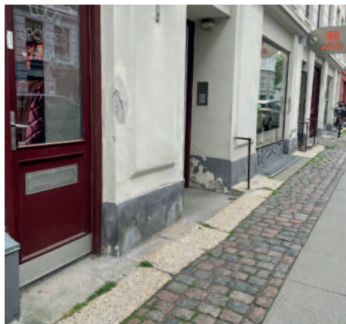
Ejendommen fugtsikres bl.a. ved etablering af omfangsdræn
