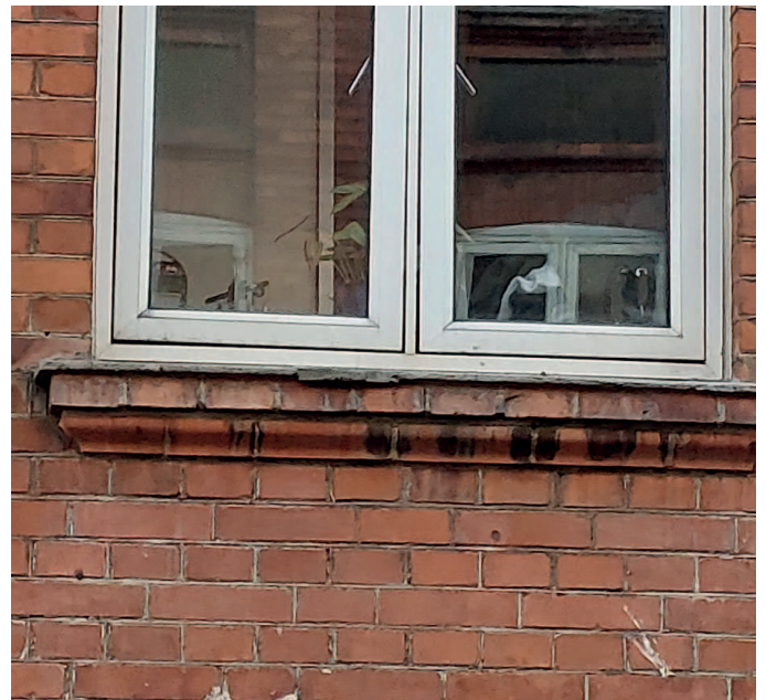
Udskiftning af vinduer
