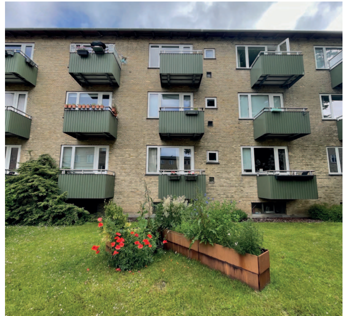
Ikke oprindelige vinduer udskiftes til trævinduer
