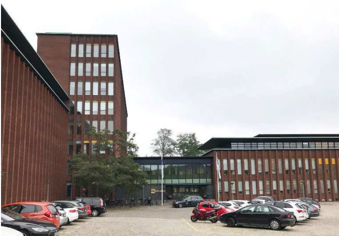
FLSmidth's hovedsæde set fra det interne parkeringsarealmød syd i dag. Foto: COBE.
