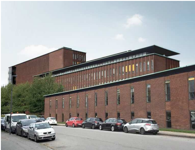
FLSmidth's hovedsæde set fra Ramsingsvej ved Vilhelm Thomsens Allé i dag. Forrest ses Laboratoriebygningen, som må fjernes, og bagved ses de to høje kontorfløje, i otte og fem etager, som skal bevares. Foto: COBE.
