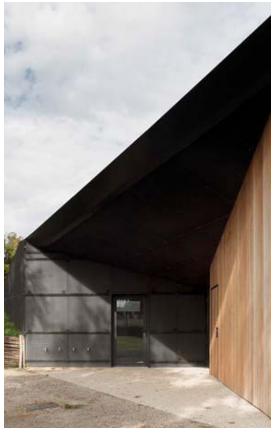
Foring i træ af niche og indgangspartier
