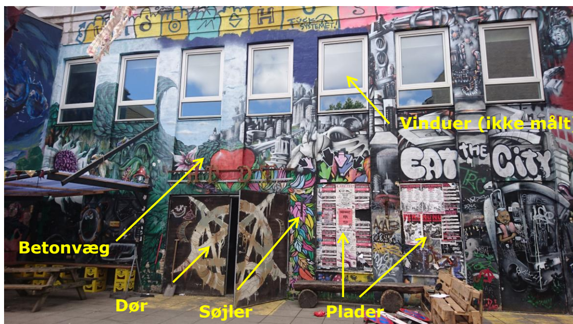
Figur 2 Facade ved Ungdomshuset, store scene.
