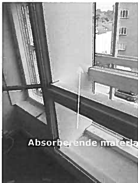
Figur 8 Absorberende materiale mellem forsatsvindue og eksisterende vindue
