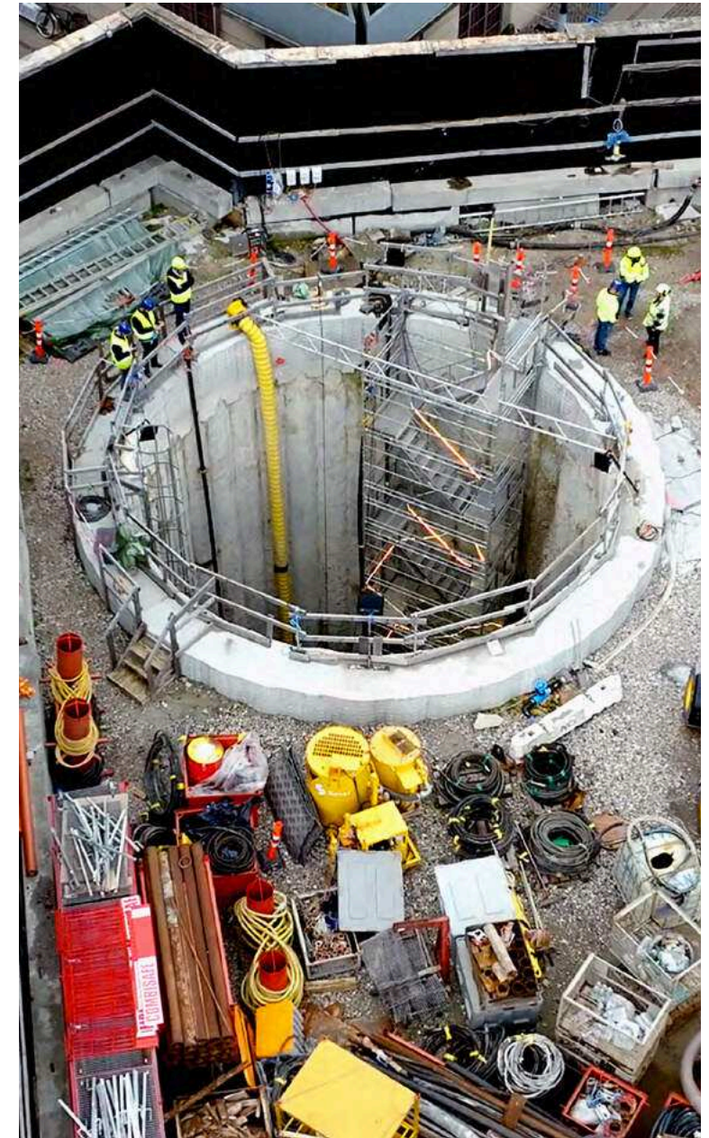
Skakt ned til Kalvebod Brygge Skybrudstunnel
