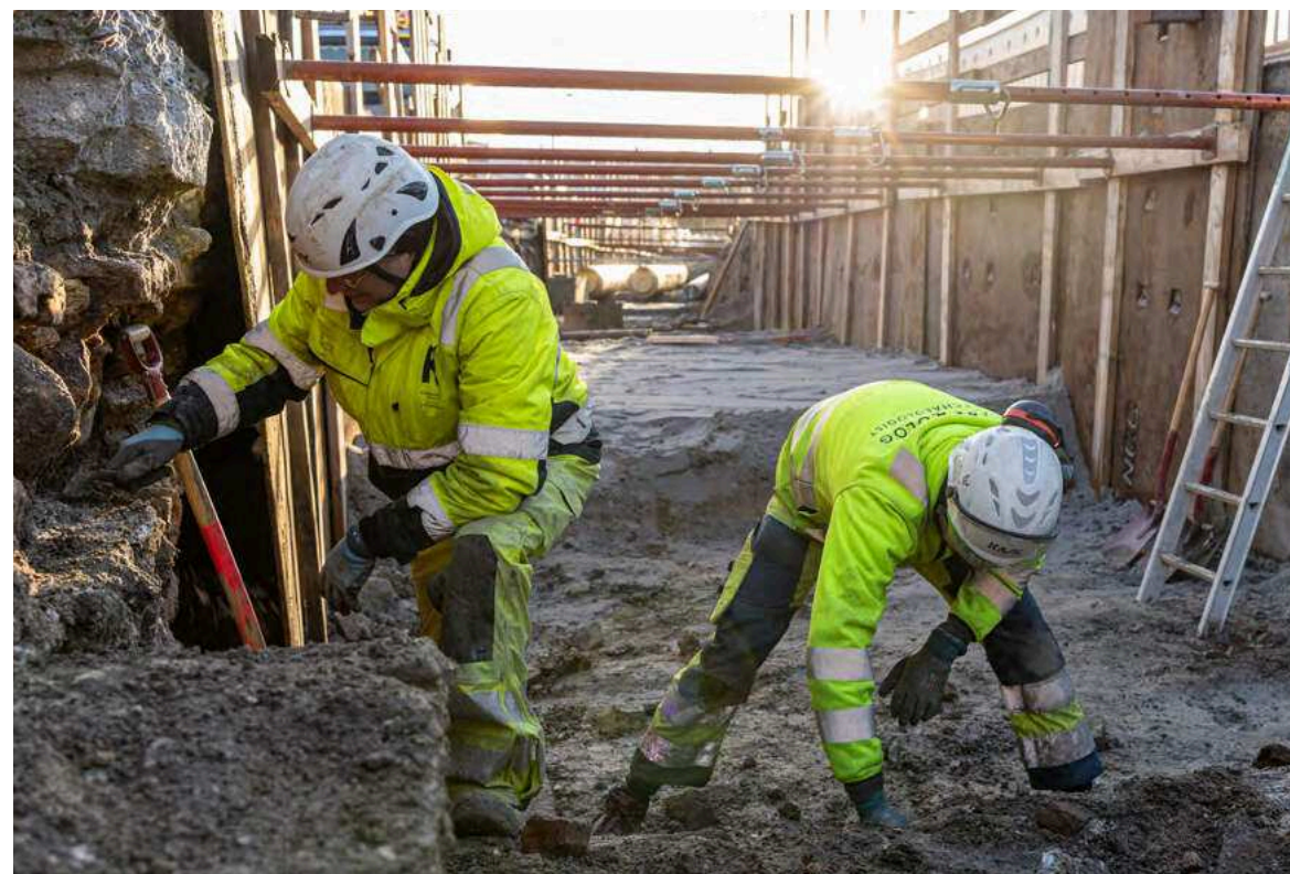
Byport fra 1724 gravet frem under gravearbejde Torvegade
