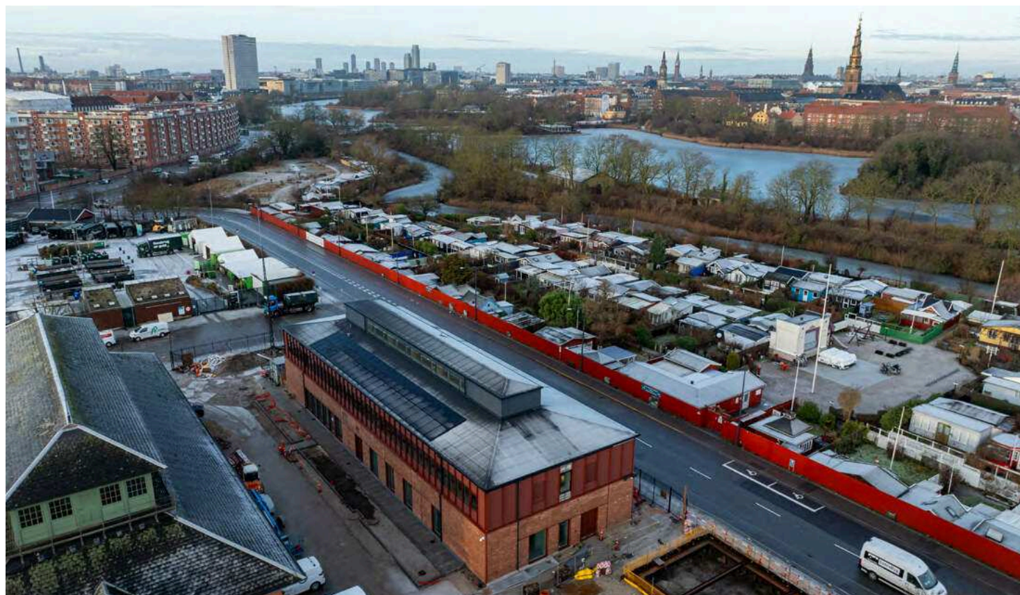
Kløvermarken pumpestation hvor den nye spildevandsvarmepumpe skal etableres
