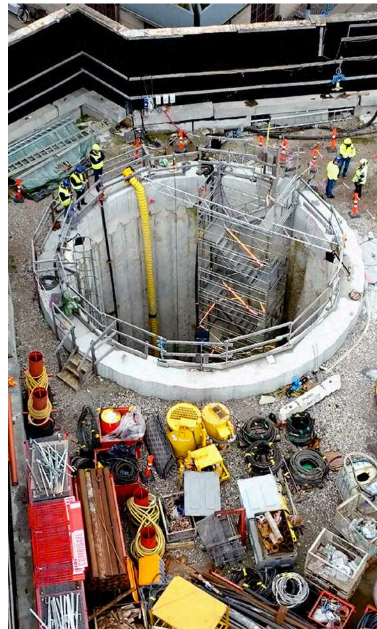
Skabt ned til Kalvebod Brygge Skybrudstunnel
