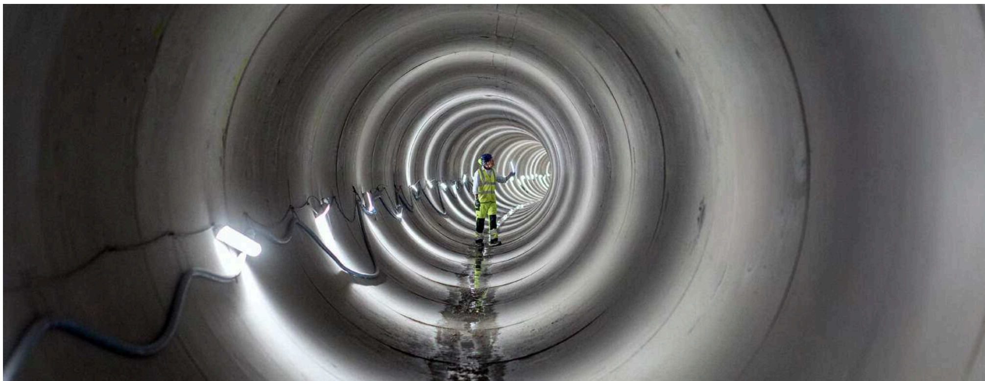
Kalvebod Brygge Skybrudstunnel
