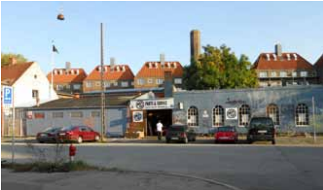
I baggrunden den bevaringsværdige bebyggelse "Fogedgården" set fra Titangades udmundning i Rådmandsgade. I forgrunden småindustri langs Rådmandsgade.
