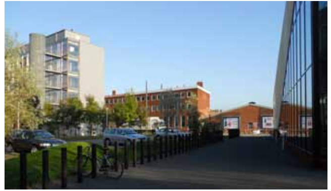
Et kig fra Metropolitets udeareal. De to røde bygninger ved Rådmandsgade forudsættes nedrevet. Industrikollegiet ses til venstre.
