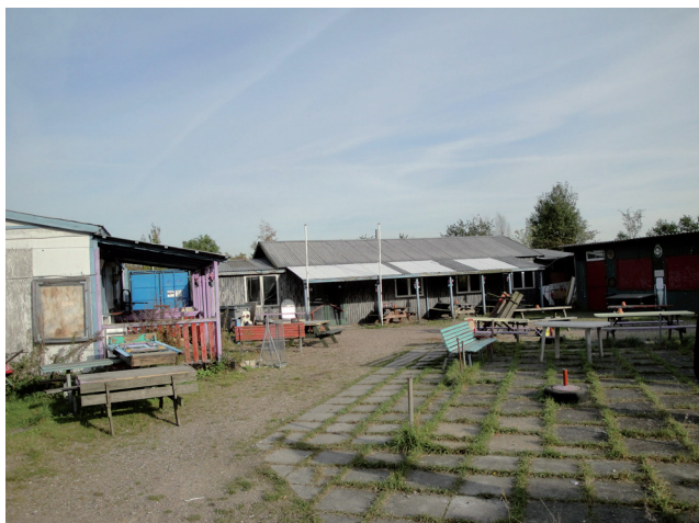
Nokkens nuværende fælleshuse, som foreningen overvejer at erstatte med nybyggeri.
