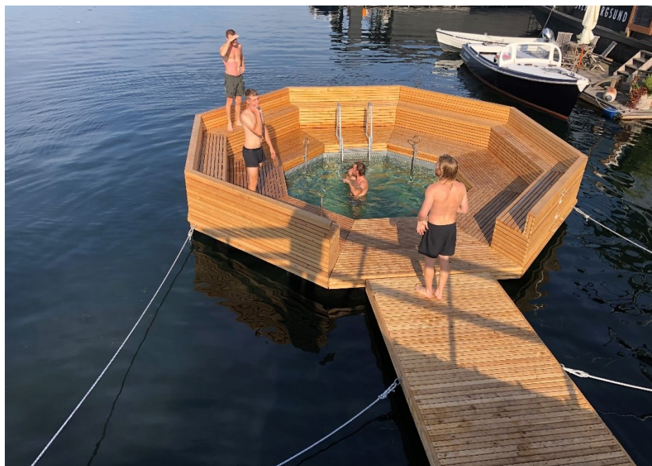
Mobil Dyppezone 1. Den første test ved Slusen. Nu placeret ved Sandkaj. Størrelse 6x6 meter. Justerbar dybde på 60-140 cm. Oktober 2020.
