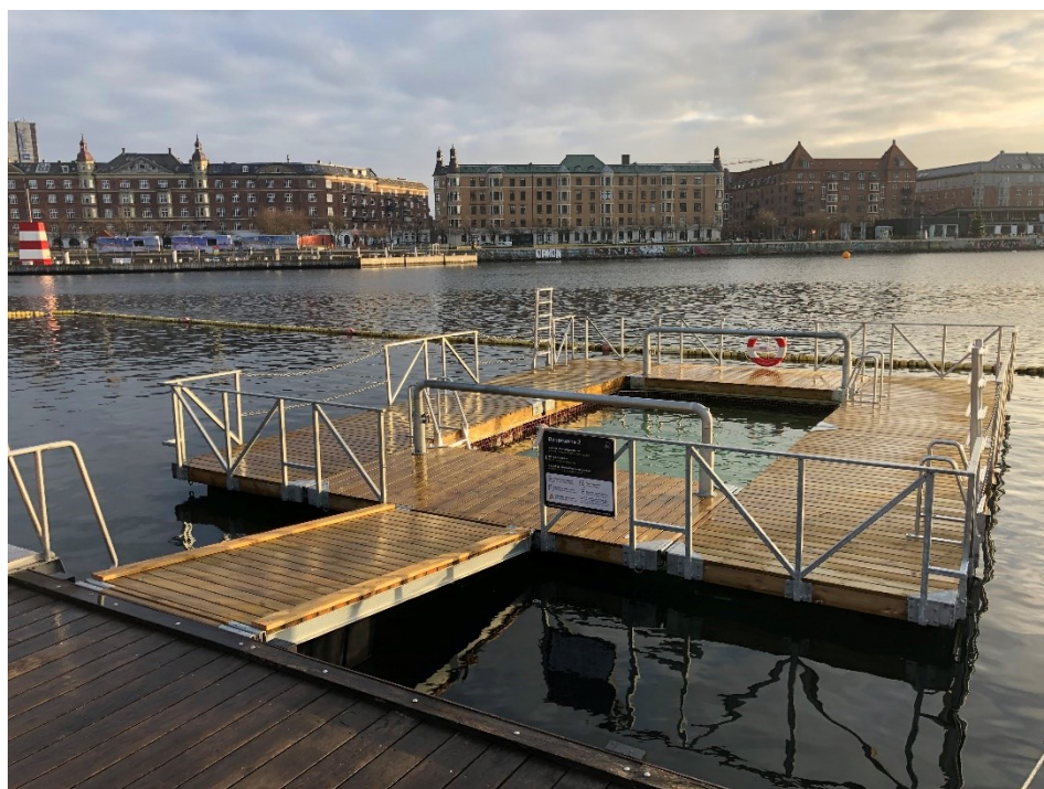
Mobil Dyppezone 2. Placeret ved Kalvebod Bølge. Størrelse 8x10 meter. Justerbar dybde på 60-120 cm. December 2020.
