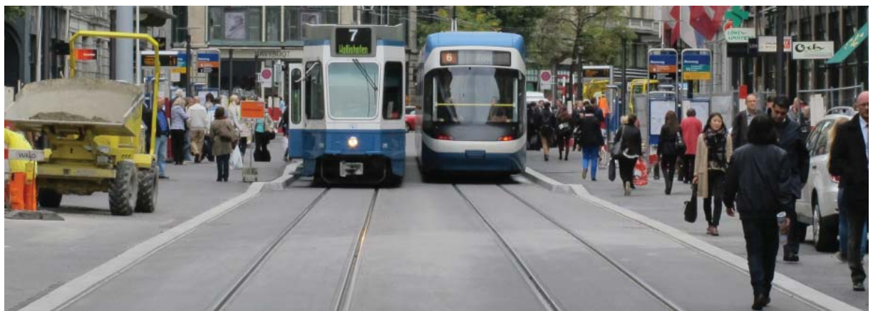
Eksempel på anvendelse af rilleskinner i Zürich, 2013.
