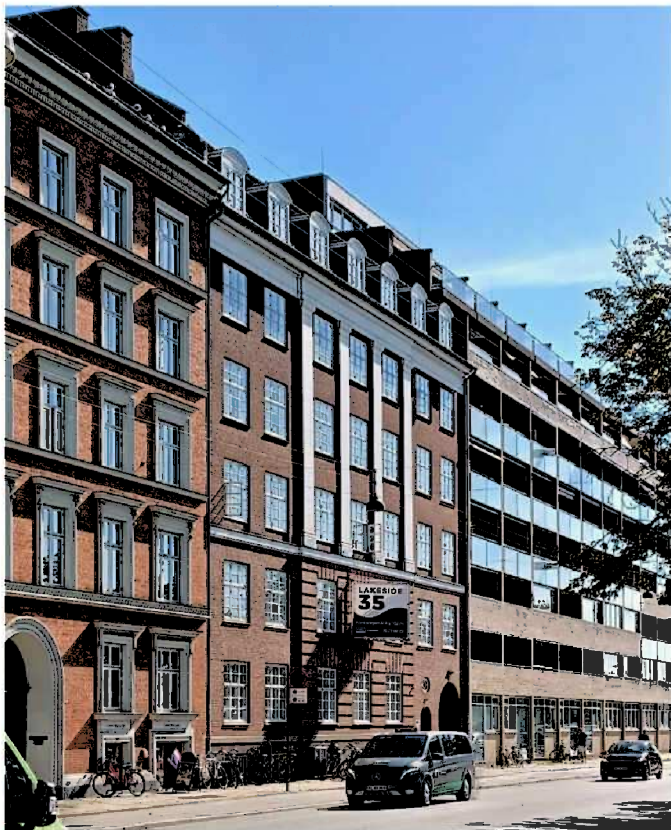
Facade mod Nørre Søgade.
