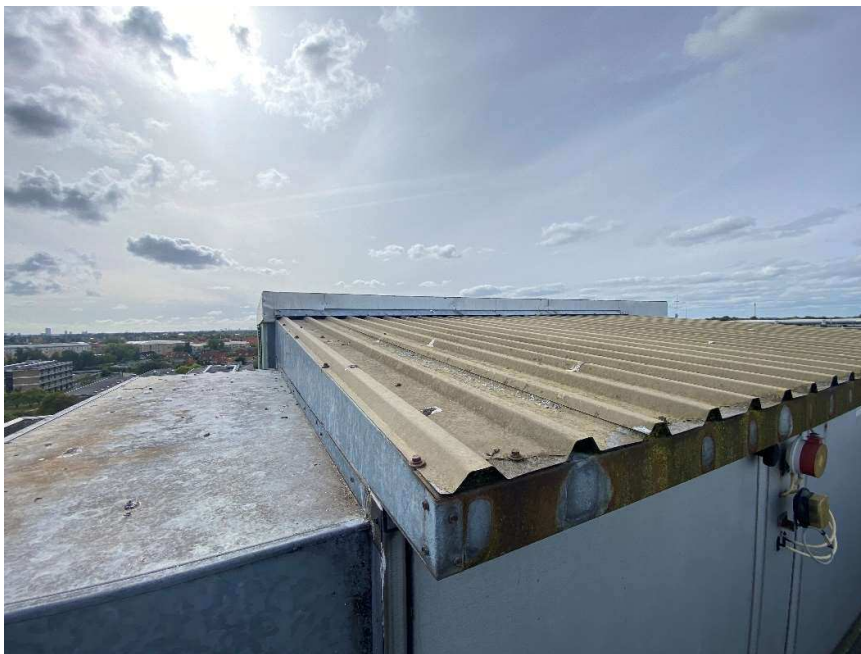
Figur 6. Der er ingen adgang for flagermus under tagpladerne.
