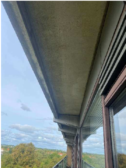
Figur 8. Udhænget af det flade tag over en balkon på den øverste etage. Der er ingen sprækker eller revner der muliggør adgang til et loftsrum.
