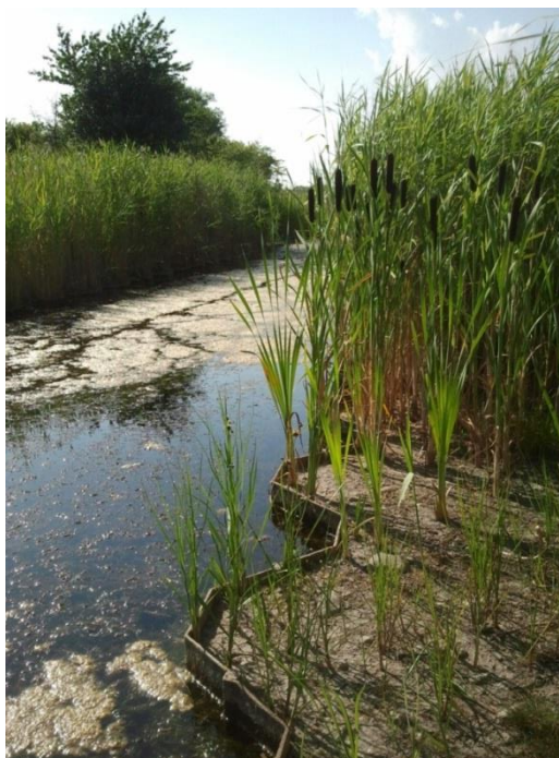
Figur 36. Den landskabelig kanal, er etableret med en hård, lodret kant af metal og beton
