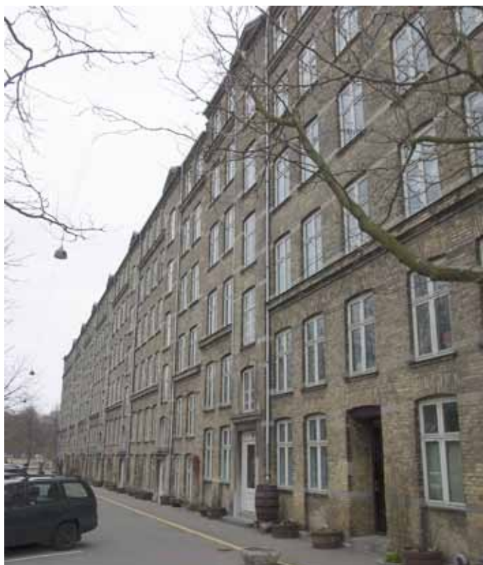
Facade mod Søpassagen
