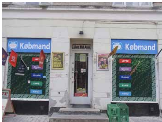
Butiksvinduer med enkeltglas
