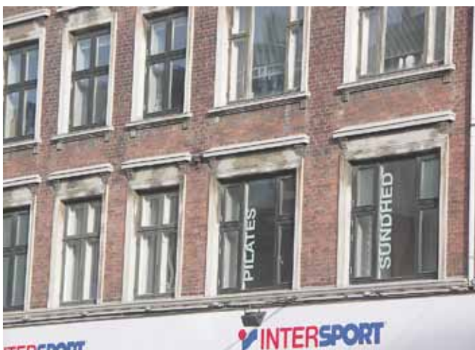
Vinduer mod gade
