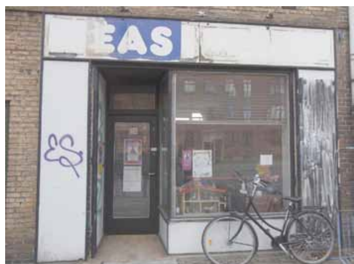
Butiksvinduer med enkeltglas
