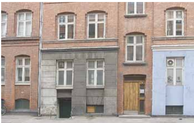
Udsnit af facade mod gade
