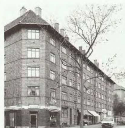
Tomsgårdsvej, set mod nord
