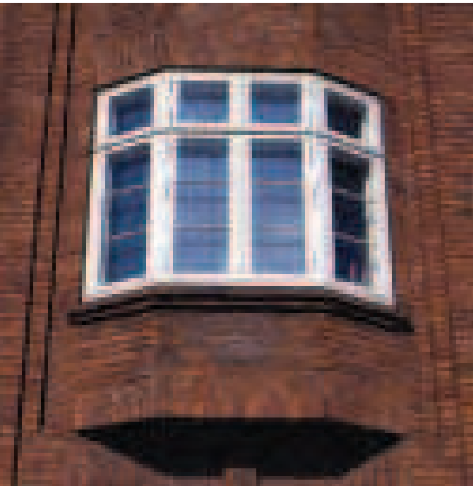
Karnap, hvor murværks detaljerne er bevaret, Ingerslevsgade.
