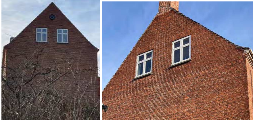
Gavl 1 og gavl 2
