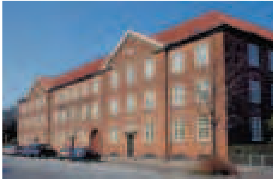
Denne bebyggelse fra 1920'erne har fået udskiftet vinduerne til nye vinduer med enkelt lag glas, sprosser og kitfals i yderste ramme, og med en fortsatsrude med thermoglas indvendigt, Hvidkildevej/Hulgårdsvej.
