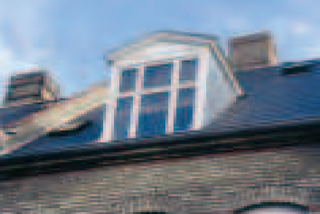
Renoveret kvist med zink på kvistens flunker, Humleby.
