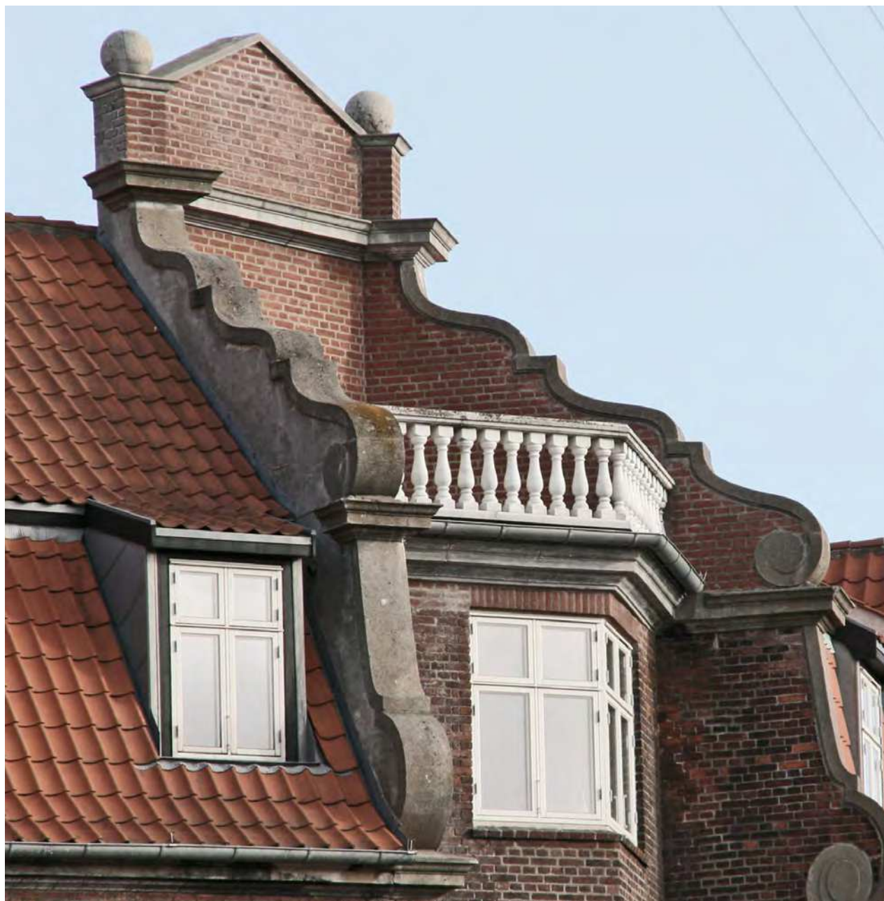
Snorregade. Oprindelig tagterrasse i mansardtag.
