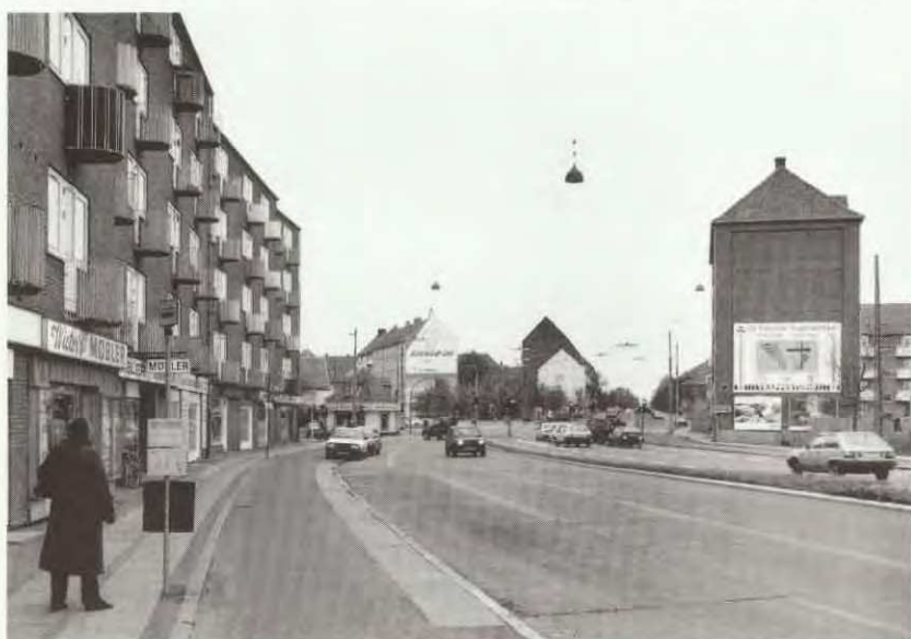
Frederiksborgvej ved grænsen til Gentofte Kommune
