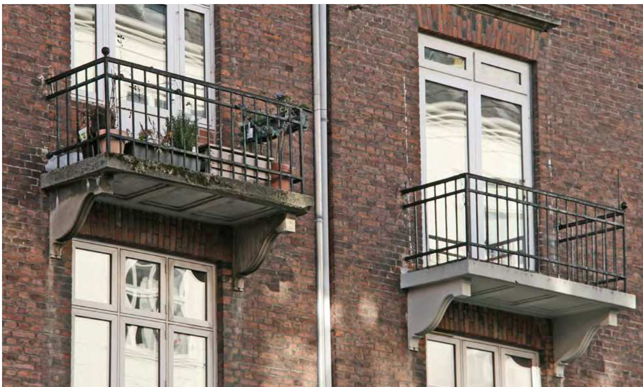
Sommerstedgade. Restaureret oprindelig altan.
