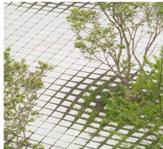
Permeable overflader som del af belægning
