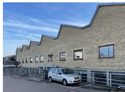
9. Fabriksbygning fra 1952, der udpeges som bevaringsværdig.
