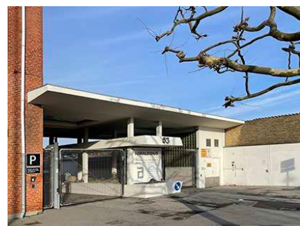
3. Port og portbygning for Lauritz Knudsens Fabrikker fra 1952, udpeges som bevaringsværdig.
