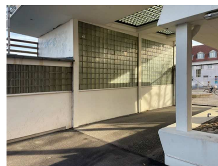
3. Port og portbygning for Lauritz Knudsens Fabrikker fra 1952, udpeges som bevaringsværdig.
