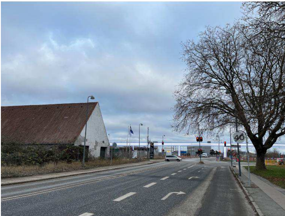
Figur 12-10 Visualiseringspunkt 6 (mod øst) før og efter – Visualisering af højbanen fra krydset ved Amager Strandvej og Prøvestensbroen set mod øst med Krudthuset i forgrunden.
