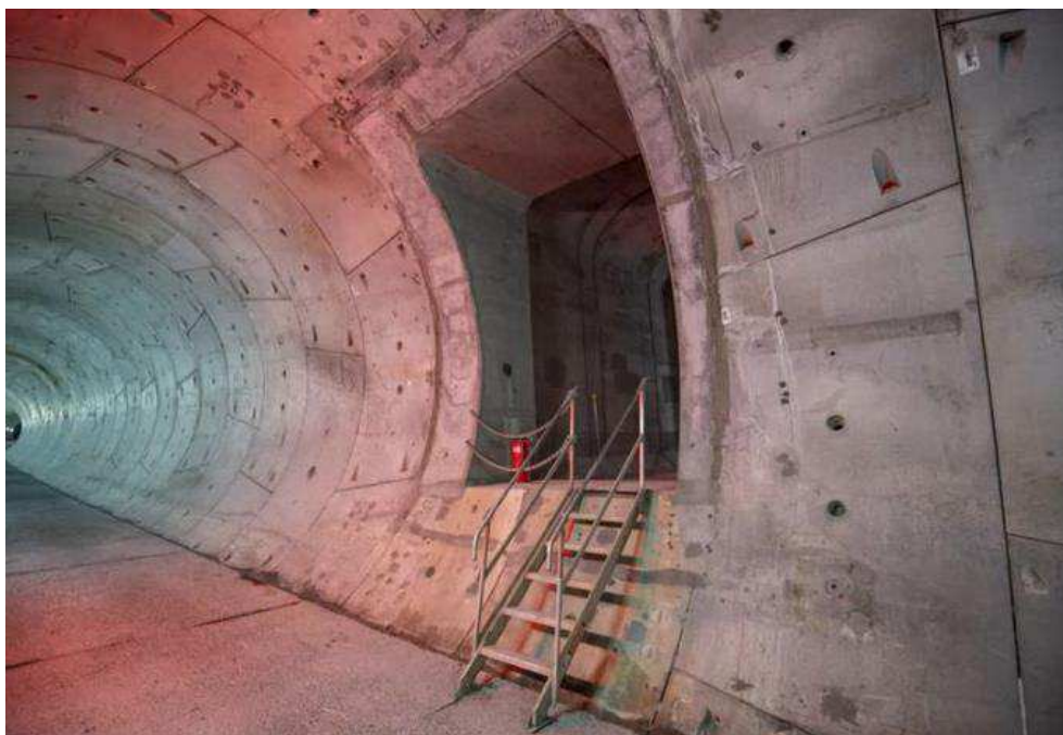
Figur 4-7 Indgang til tværtunnel set fra hovedtunnelen. Billedet er fra anlægsfasen af en tværtunnel.
