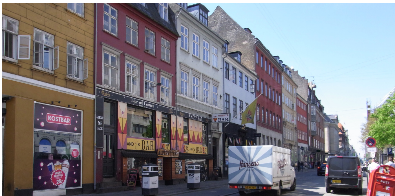
Facaden mod Gothersgade med kig mod Nørrevold. De bevaringsværdige huse er opført efter den store brand i 1728. Husene har ensartet materialekarakter med pudsede facader i forskellige farver, hvilket giver facaderækken et helhedspræg, uanset senere ombygninger. Skiltningen er meget dominerende og er opsat uden hensyntagen til ejendommens arkitektur.
