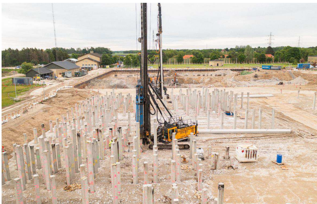
Figur 2 Funderingsarbejde med pæleramning er nu afsluttet – 1800 pæle er kommet i undergrunden
