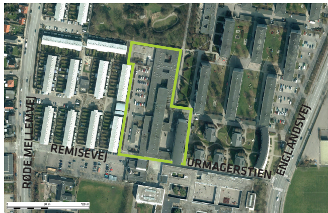
Solvang Centret placeret ud til Remisevej hengemt fra Røde Mellevej og Engelsvej
