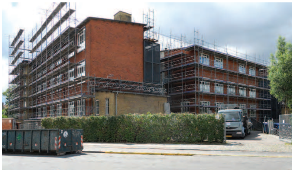
Skolens hovedbygning set fra Randbølvej. Hele det oprindelige bygningsanlæg fastlægges som bevaringsværdigt i lokalplanen. Hovedbygningens facader er under renovering i sommeren 2012.
