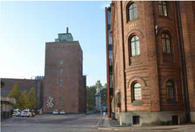
I delareal IIC ved Pasteursvej ligger den fredede Maskincentral (t.v.) og det fredede Malteri (th.).
