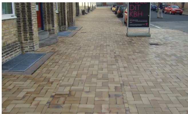
Belægninger på Bispebjerg Torv
