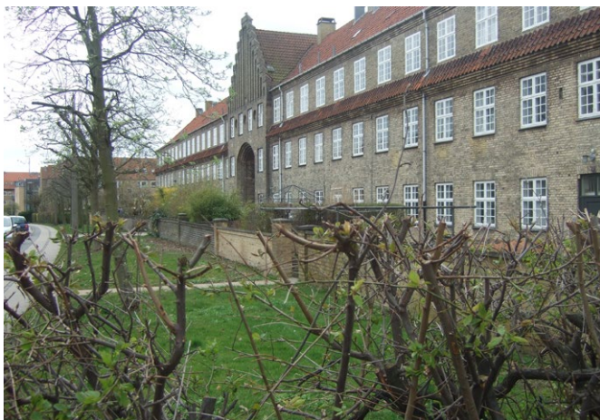
Bebyggelse mod Peter Rørdams Vej - bemærk de teglhængte gesimser og de lave mure, der afgrænser haverne
