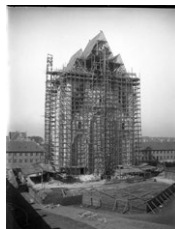
Grundtvigs Kirke kirken under opførelse
