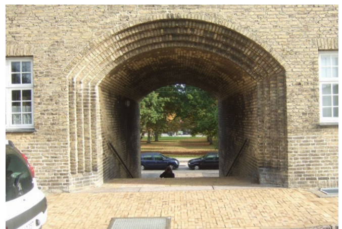
Port med adgang fra På Bjerget til Peter Rørdams Vej
