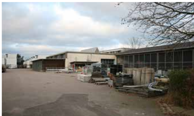
Eksisterende værkstedsbygninger på lokalplanområdet
