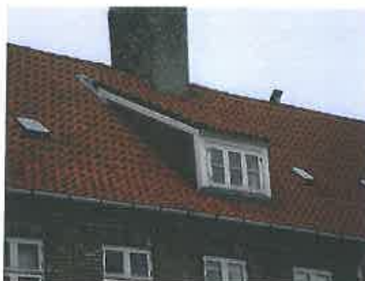
På Bjerget 3 Taskekvist med murede flunker
