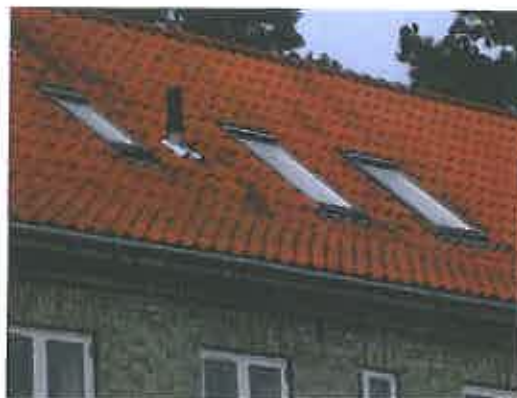
Jeppes Allé 1-5 Forskellige tagvinduer mod gård
