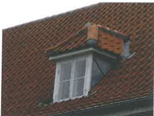
Peter Rørdamsvej 24-28 Saddeltagskvist med flunker inddækket i zink
