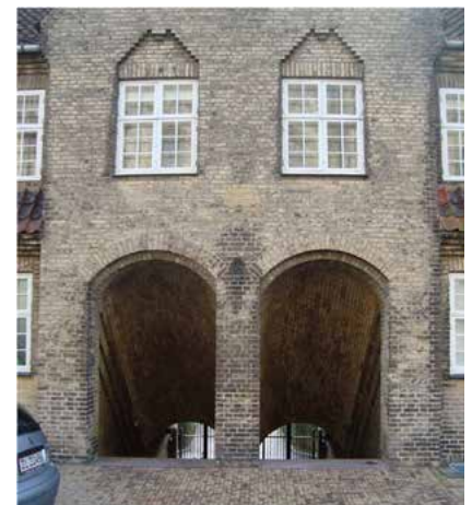
Porte med adgang fra På Bjerget til C. J. Birkedalsvej - bemærk murdekorationer over vinduerne og de murede buer i portene.
