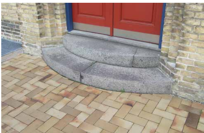
Gode materialer og fine detaljer ved indgangsdør.
