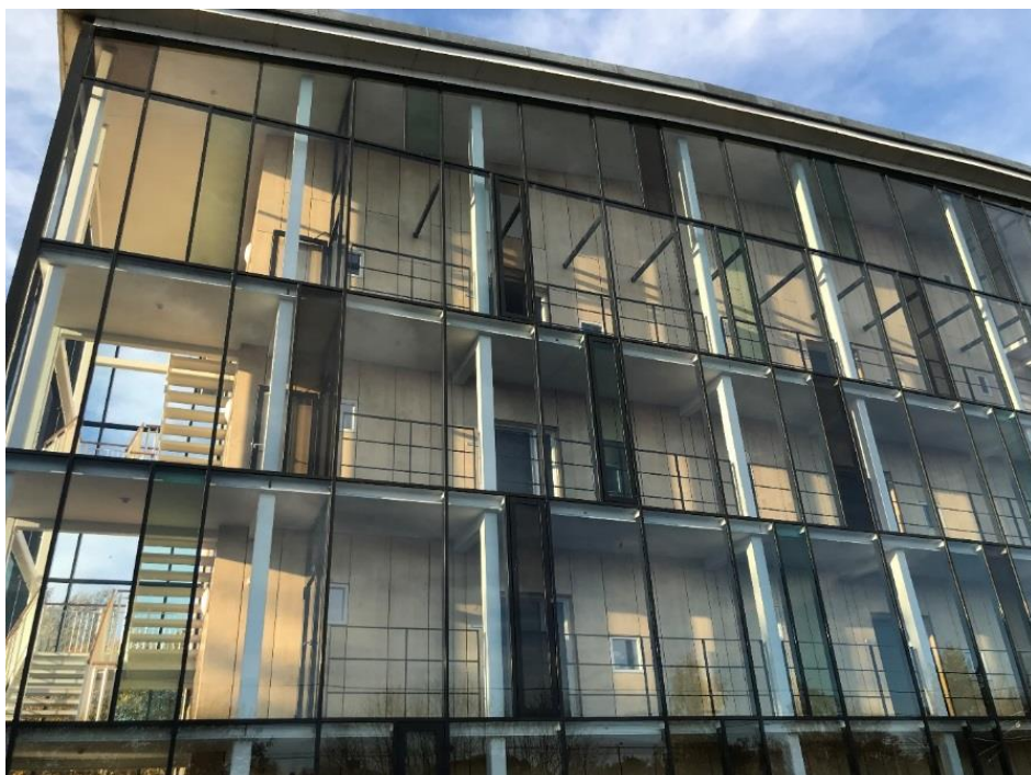
Figur B3 Billedet viser Baune Allé 2, 2800 Kgs. Lyngby som et eksempel på en boligejendom med altangang som støjbeskyttelse mod vej og jernbane. Foto: Rambøll.
