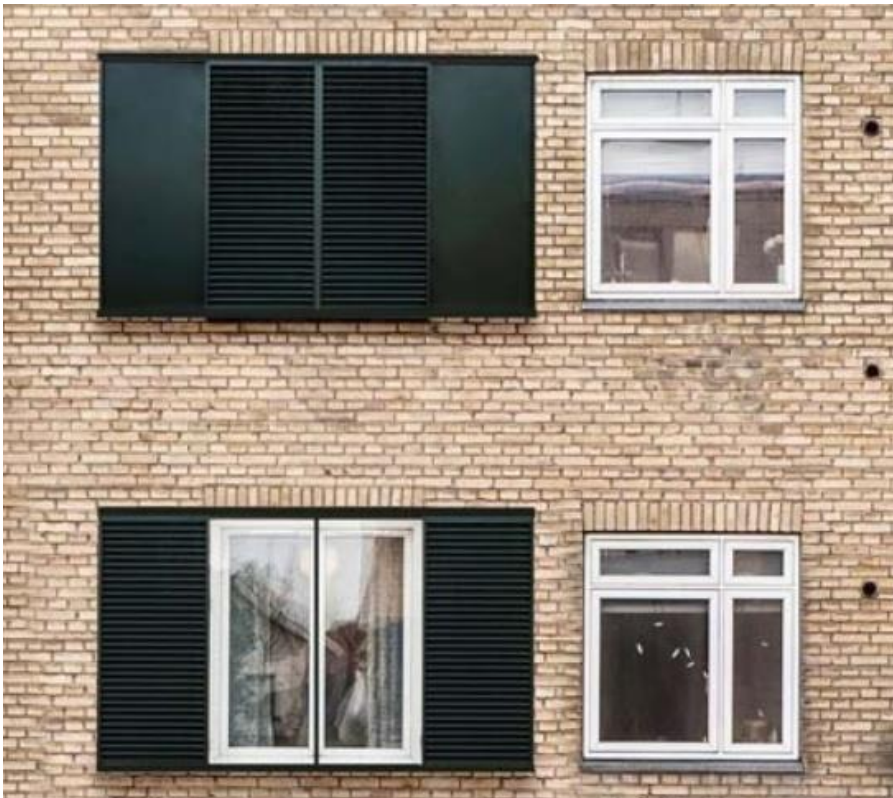
FIGUR B8 Billederne viser lydskodder, som er lukket for og åbnet op. Eksempel fra Art Andersen A/S.
