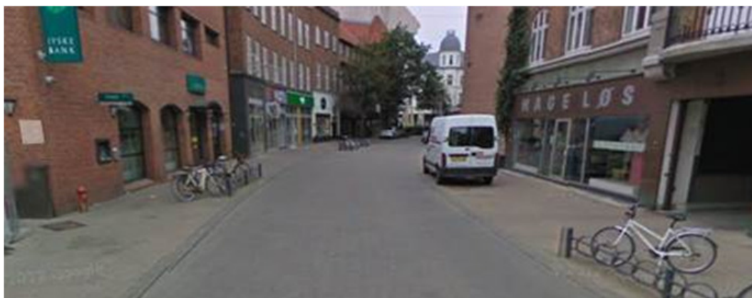
Figur 10 Referencefoto fra Odense, Mageløs Et eksempel på en vej uden traditionelle kantsten, men med klart markeret kørebane.
