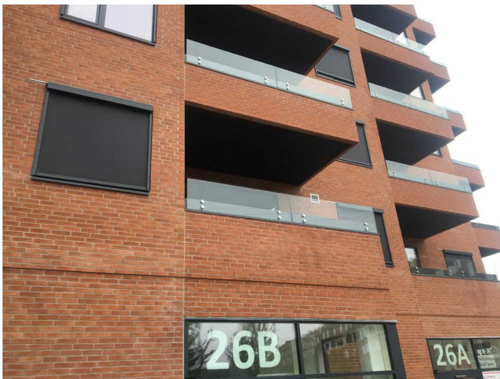
Figur B6 Billedet viser et eksempel på altaner med lydabsorberende loft – Thorvaldsensgade 26, 8000 Århus. Med lydabsorberende beklædning på loftet kan altanen yde en mindre tillægsgdæmpning. Foto: Rambøll.
