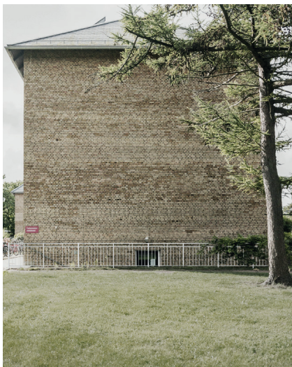
Gavl før efterisolering
