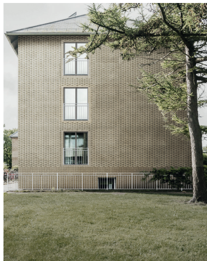
Gavl efter efterisolering med mønstermurværk og franske altaner
