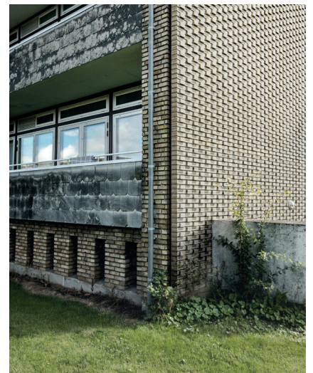
Eksempel på hjørneløsning ved efterisolering af gavl
