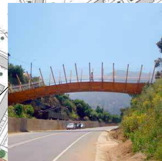
Gangbro over vej
