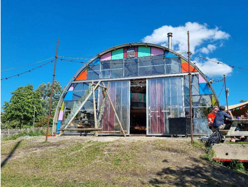
Noorderlicht Café - bygget og indrettet med cirkulære materialer
