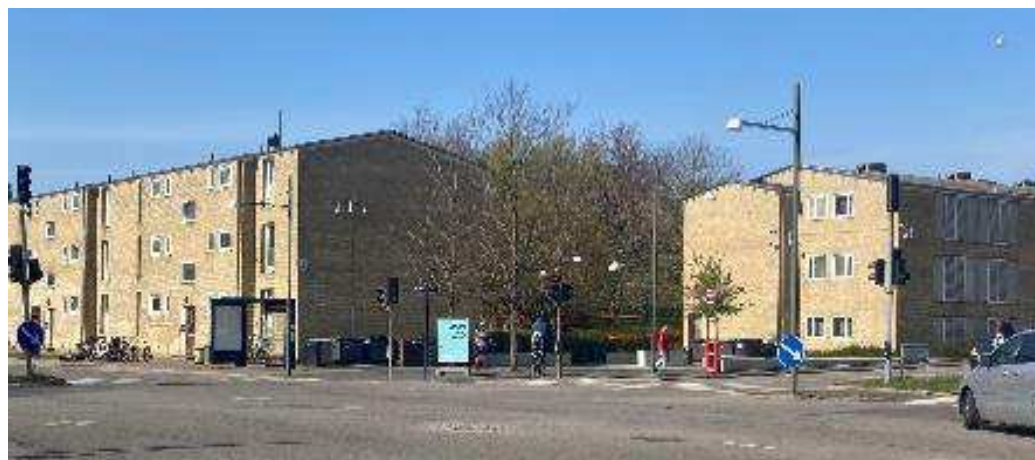
Nuværende facade på Åkandevej set mod syd/vest
