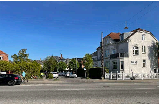
Englandsvej 27 på hjørnet af Søren Norbys Allé. Stor voluminøs villa som genbo til Engelsdsvej 25. Foto: Lantz Arkitekter.
