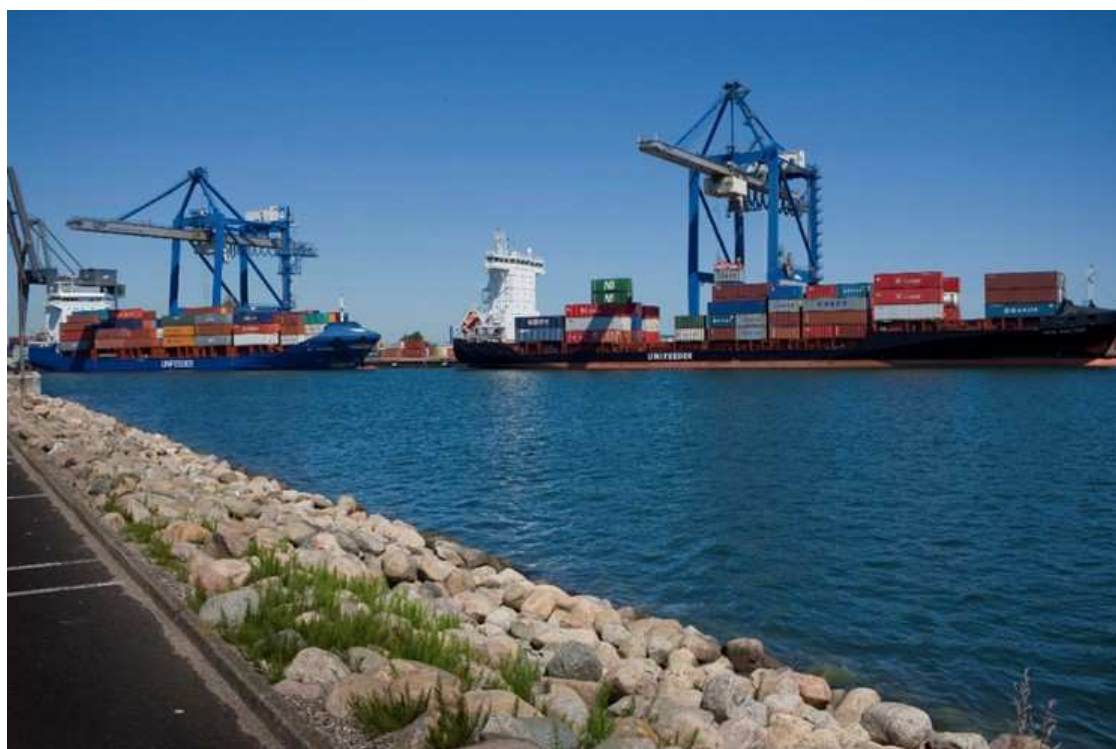
Figur 2.2: Eksempel på STS-kraner. Her fra den eksisterende containerterminal på Levantkaj i Nordhavn.
