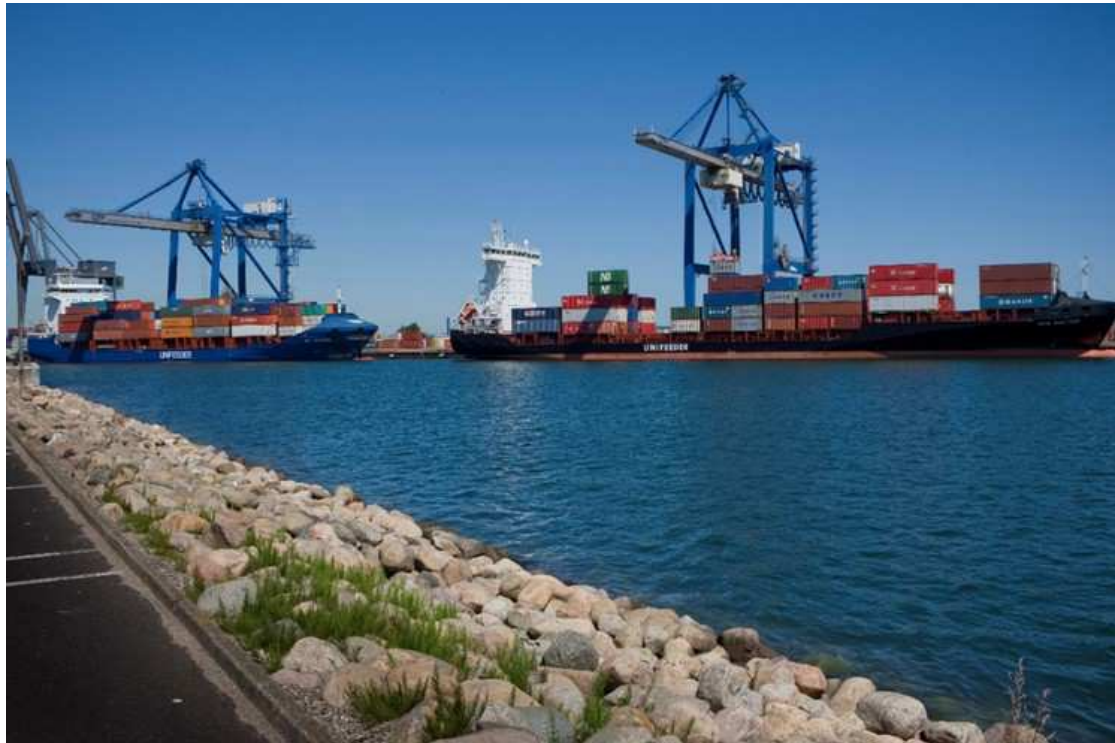
Figur 3-2: Eksempel på STS-kraner. Her fra den eksisterende containerterminal på Levantkaj i Nordhavn.
