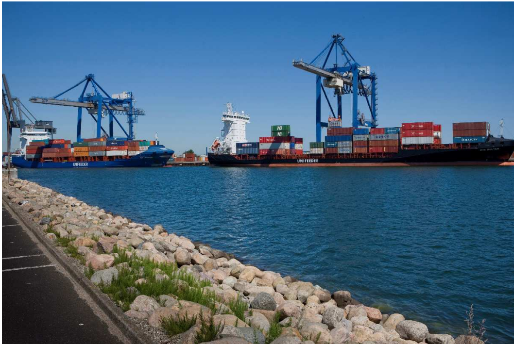
Figur 3 - Eksempel på STS-kraner. Her fra den eksisterende containerterminal på Levantkaj i Nordhavn.
