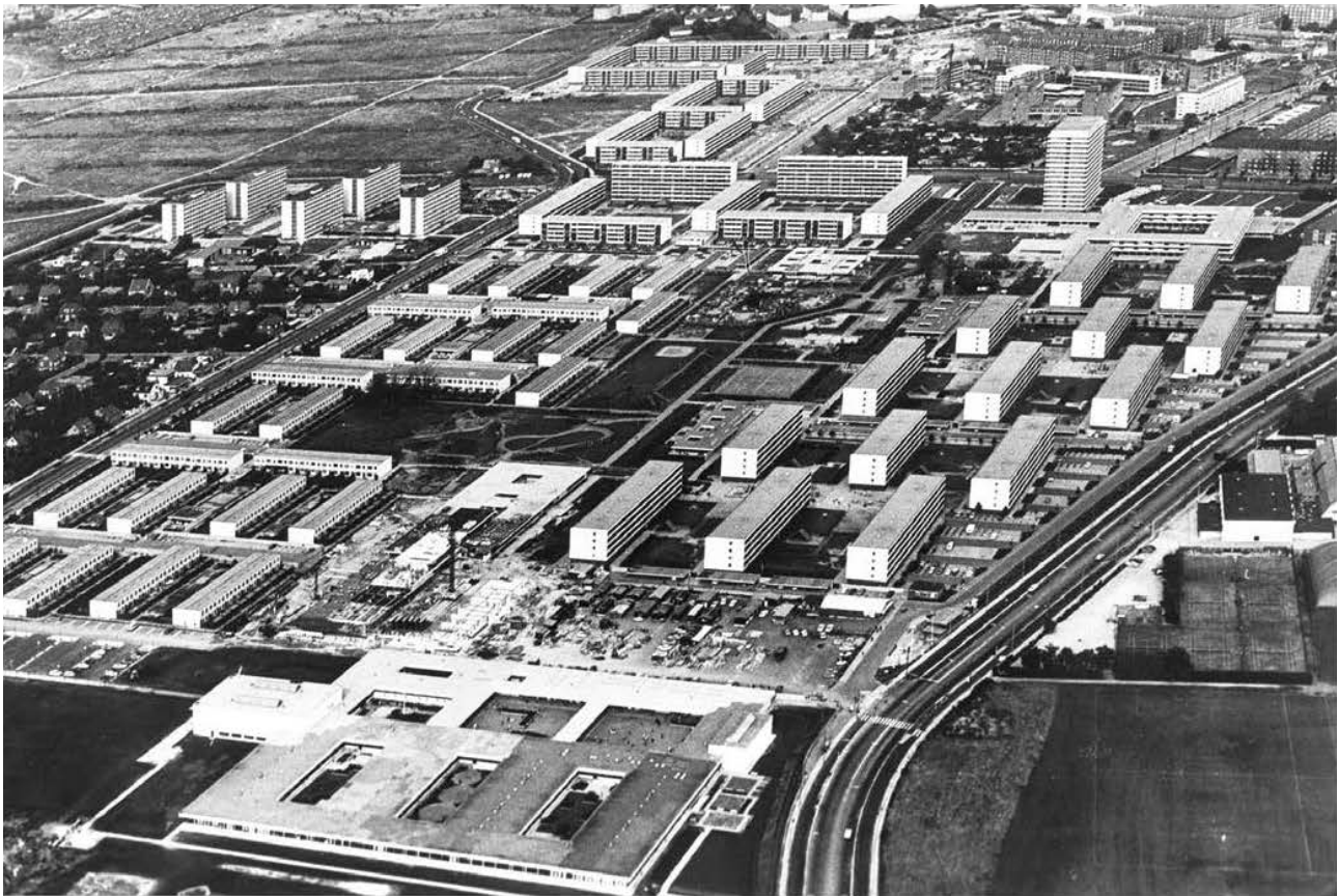
Luftfoto af Urbanplanen taget under anlæggelsen af Solvang Centret.
