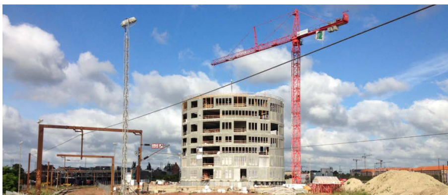
Trafiktårnet opføres af BaneDanmark ved Dybbølsbro, hvor Vejdirektoratet og Københavns Kommune lejer en dobbeltetage i tårnet til den fælles trafikcentral (foto 12. juni 2014).
