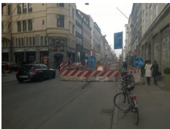
Figur 12. Gravearbejde på Bredgade nf. Kgs. Nytorv inden Sankt Annæ Plads. Kapaciteten var under besigtigelsen yderligere nedsat end normalt.
