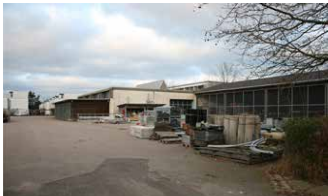
Eksisterende værkstedsbygninger på lokalplanområdet
