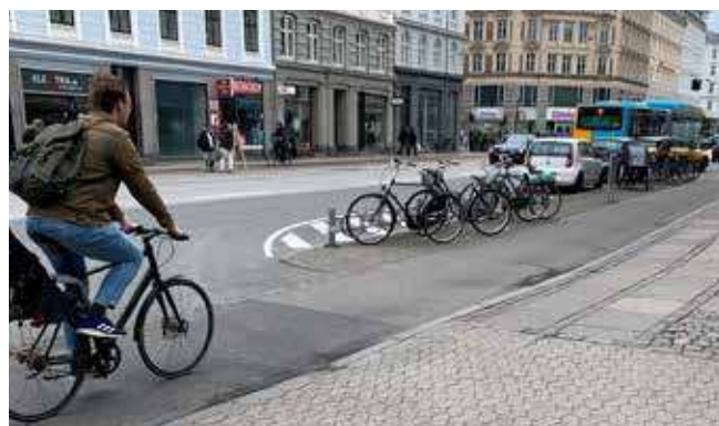
Cykelparkering kombineret med spærreflade, Frederiksborggade/Nansensgade
