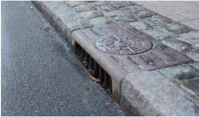
Sideindløbsbrønd på Stormgade
