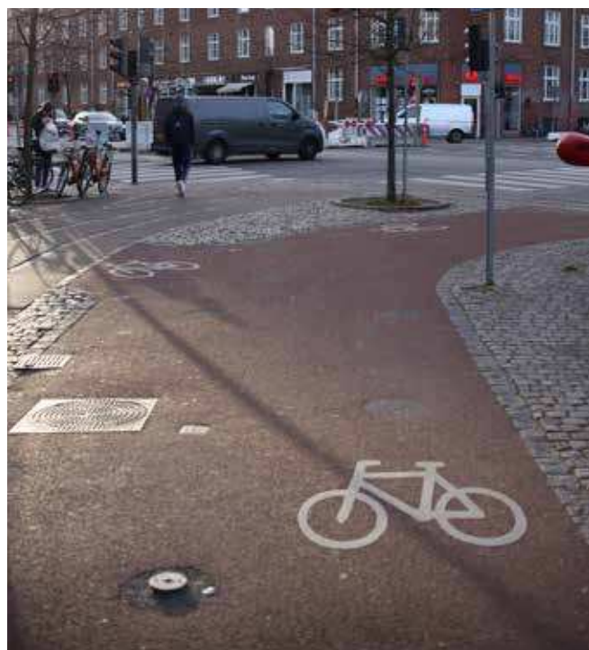
Rød asfalt ved Cirkelines Plads
