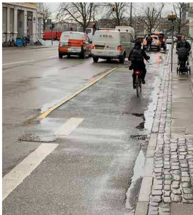
Forstærket cykelbane ved busstoppested på Classensgade
