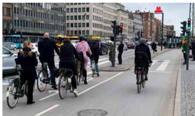
Kanalisering i venstresvings- og bred ligeudbane, H.C. Andersens Boulevard/Vesterbrogade
