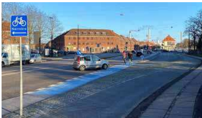
Cykelsti mellem ligeud og -højresvingsbane, Hillerødgade/Borups Allé
