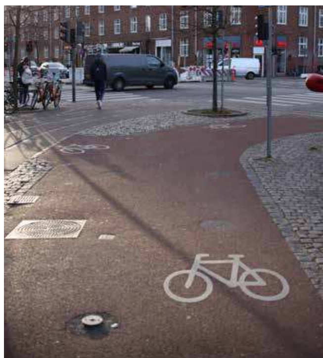
Rød asfalt ved Cirkelines Plads
