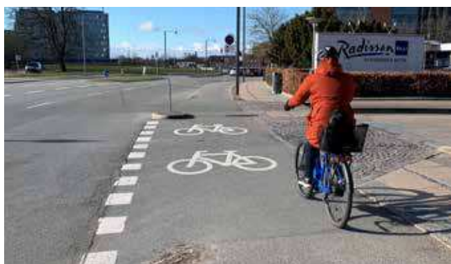
Halvt cykelfelt ved overkørsel på Ørestads Boulevard
