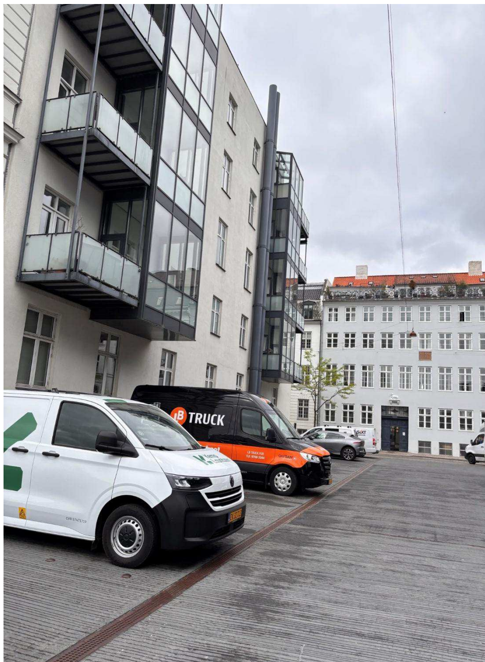
Foto 2: Udtræksrør fra anlægget
