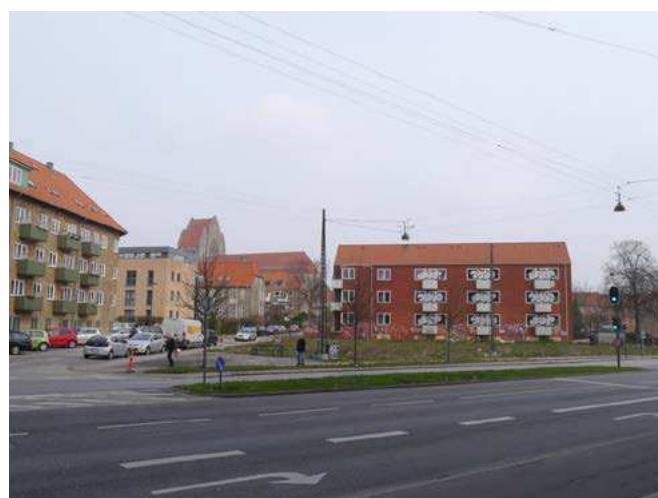
Byggegrunden set fra Tuborgvej. Den eksisterende bygning Journalistgården er tilladt nedrevet. Foto: Vilhelm Lauritzen Arkitekter
