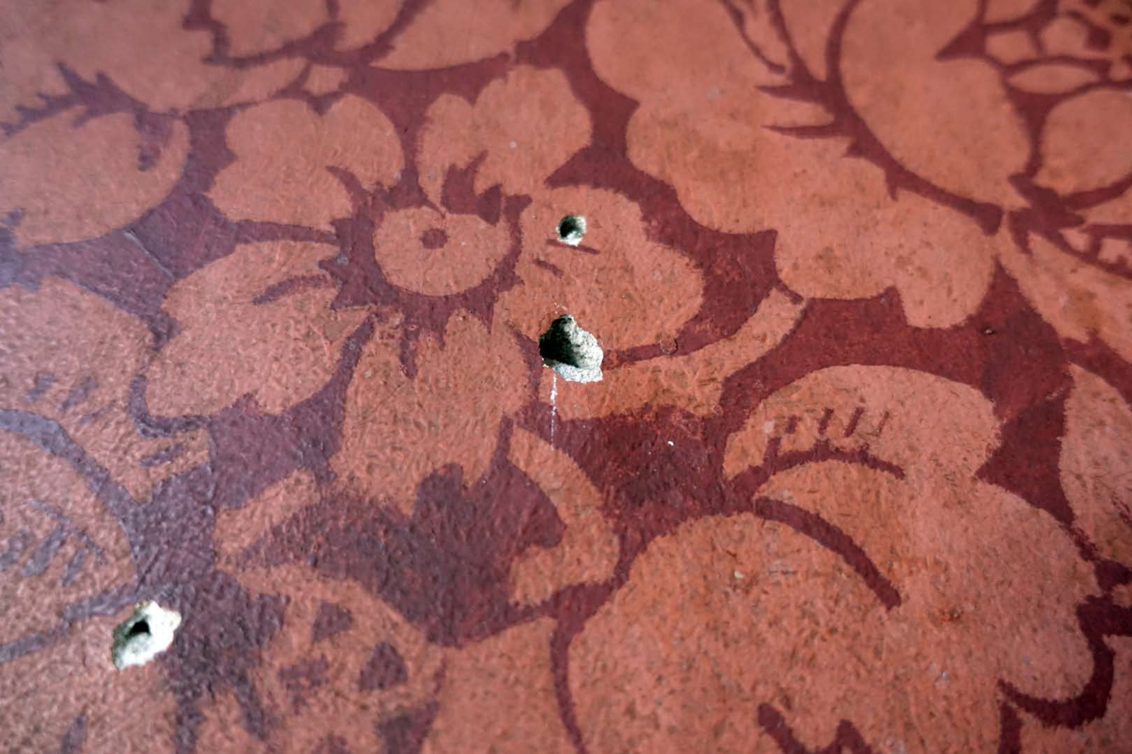
Inger Hansens Minde, Oliefabriksvej 2, 2770 Kastrup
