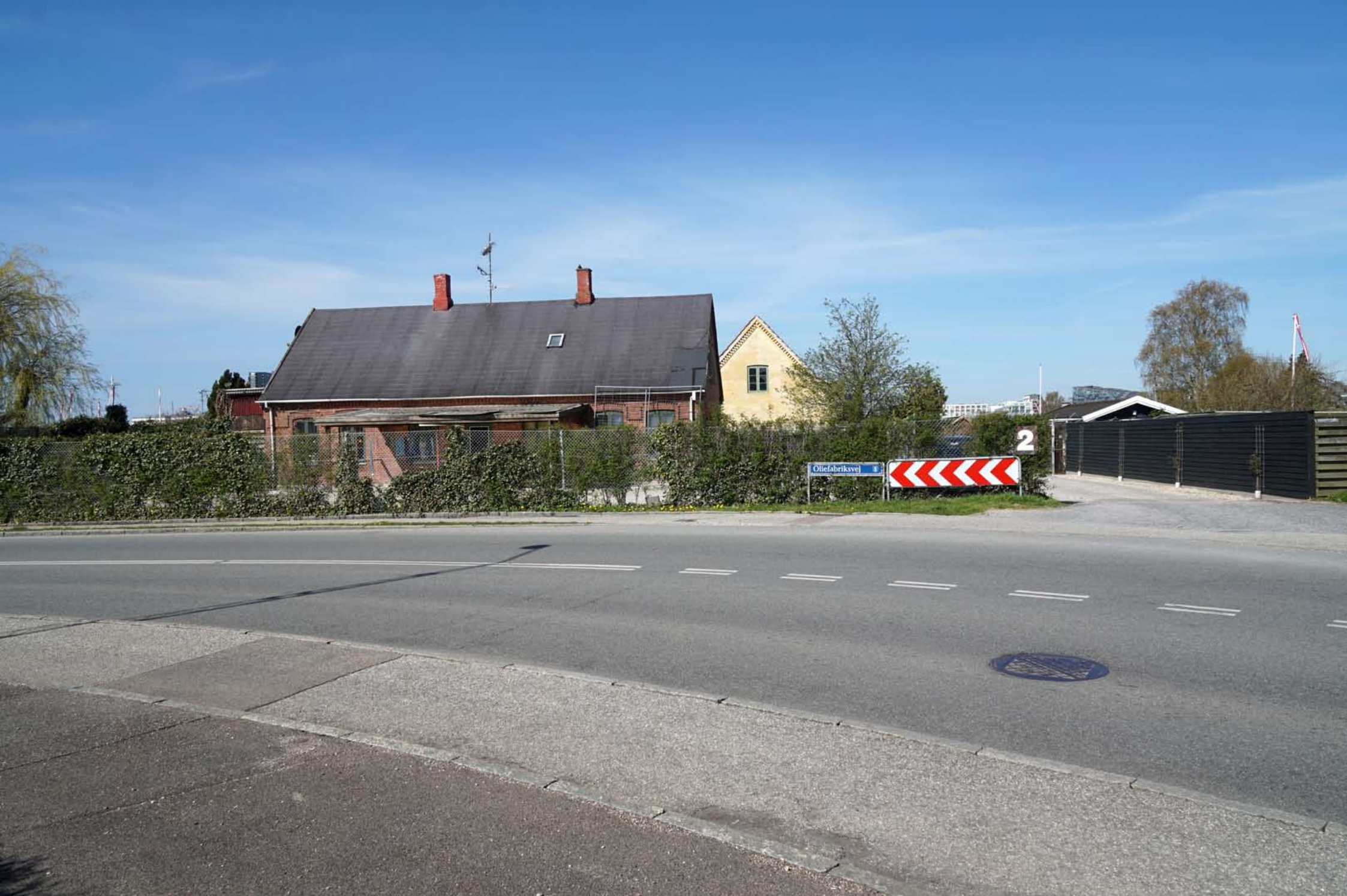
Inger Hansens Minde, Oliefabriksvej 2, 2770 Kastrup
