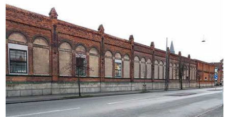
Hamletsgade 9 – Spinderibygning I.
