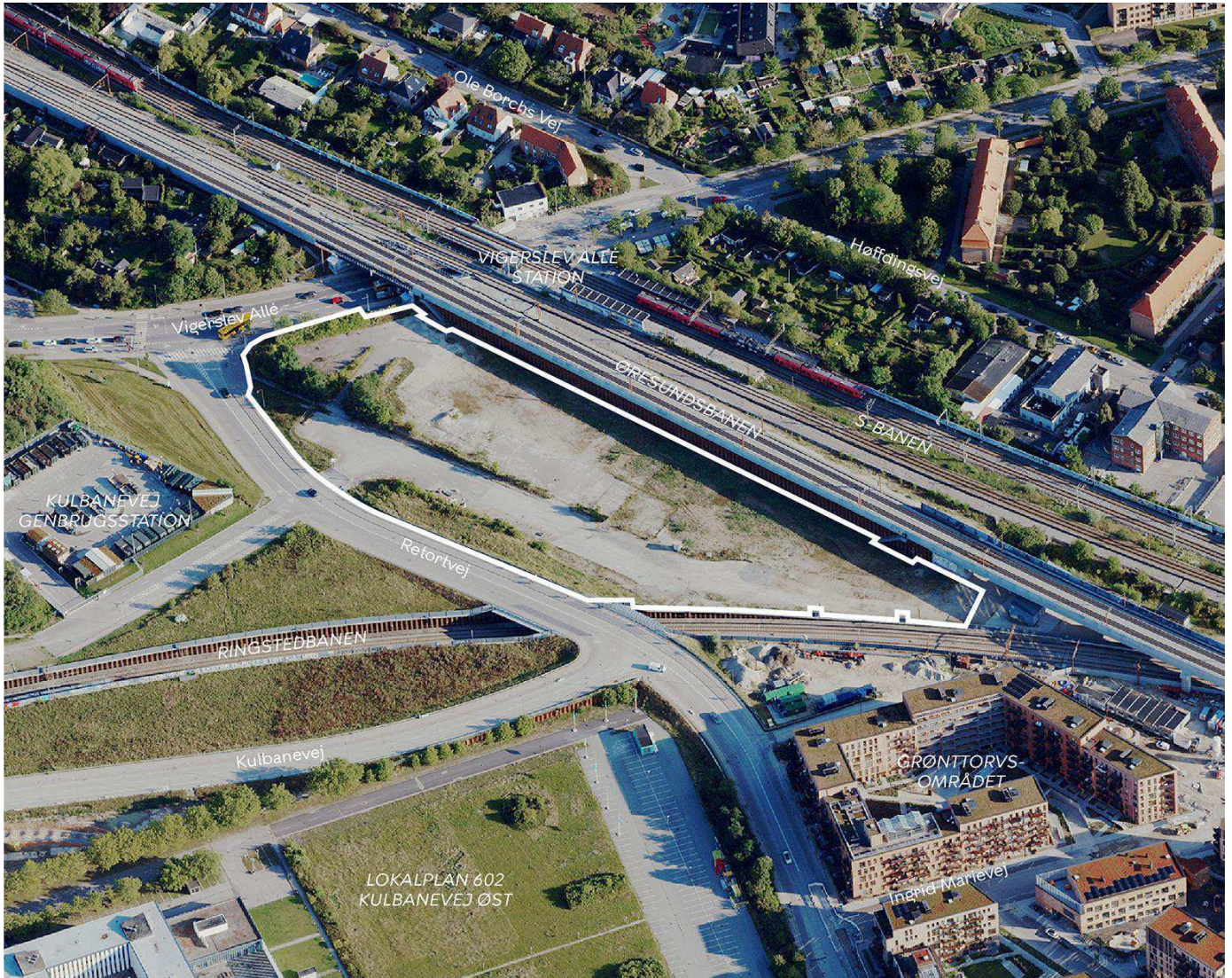
Området set mod nord. Lokalplanområdet er indtegnet med hvid linje, og de vigtigste gader og bygninger m.v. er navngivet. Luftfoto: Styrelsen for Dataforsyning og Infrastruktur, 2021.
