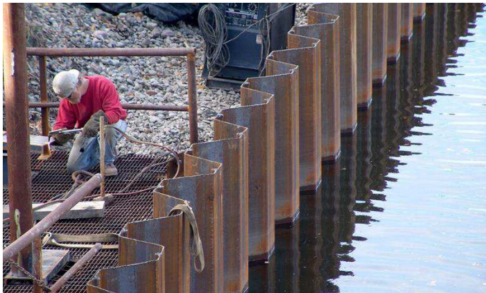
Figur 7-15 Byggegruber laves med spunsvægge for rampe konstruktioner
