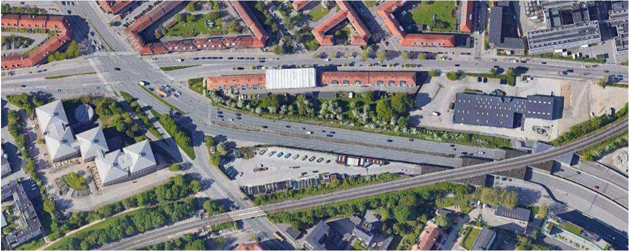
Figur 6-1 Hillerødgade, Bispeengbuen og Ringbanen
