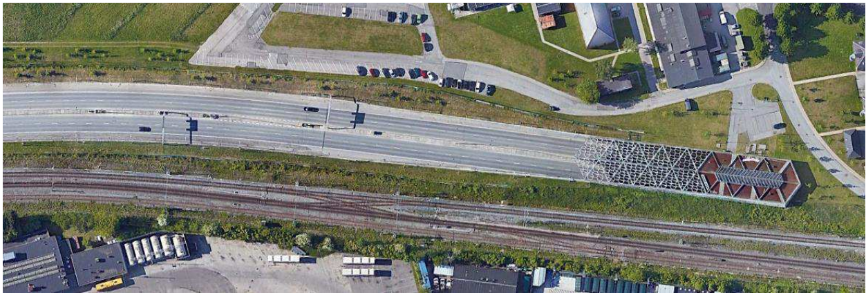
Figur 7-5 Nordhavnsvej – Vestlige portal fører hovedtunnelen til overfladen (Google Earth).
