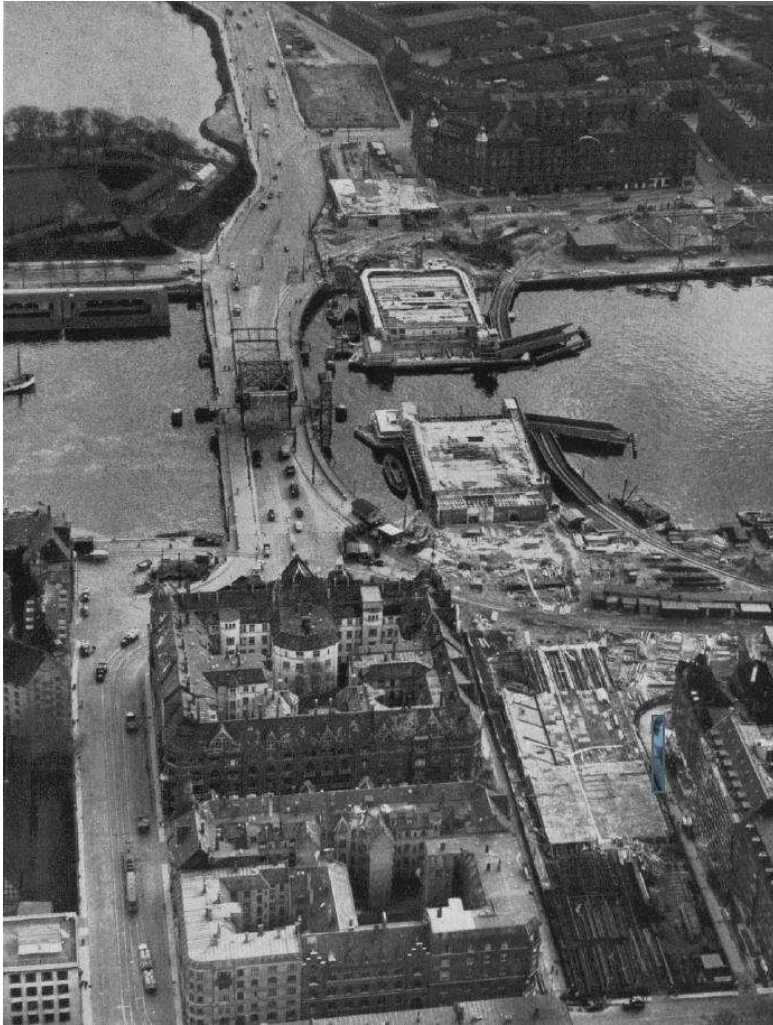
Figur 3-13 Anlæg af ny Langebro i 1953 set fra vest mod øst. Her ses Interimsbro, ny Hovedbro og jernbanebro. [4]
