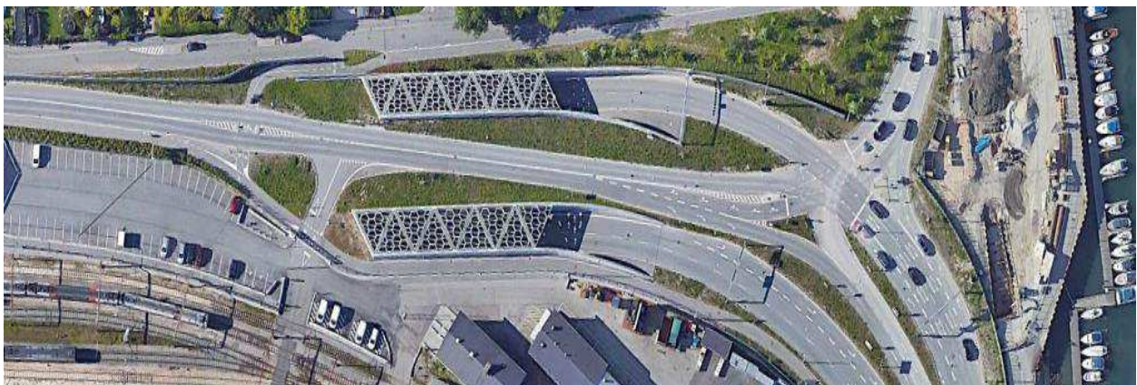
Figur 7-6 Nordhavnsvej – Østlige portal fører sideramper til overfladen. Hovedtunnelen er ført videre for fremtidig tilslutning til Nordhavnstunnel (Google Earth).
