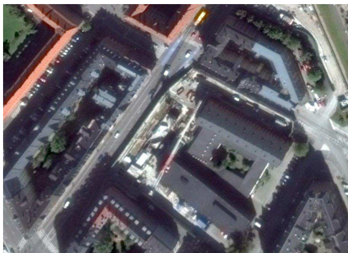
Figur 3-4 Udgravning til metrostation ved Nuucs Plads
